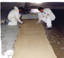
REPARACION CON MORTERO
