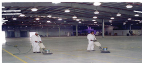
LIJADO PARA LIMPIEZA DE IMPUREZAS
