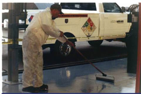
Poliuretano en talleres mecanicos - AGENCIA NISSAN ZONA RIO
