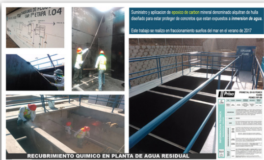
RECUBRIMIENTO QUIMICO EN PLANTA DE AGUA RESIDUAL
